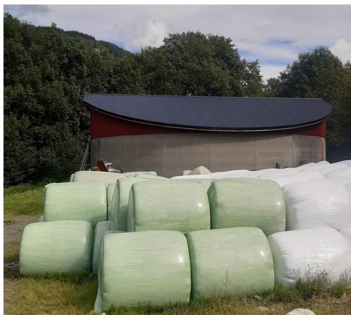
Føretaket her har fått SMIL tilskot til å byggje tak på gjødselkumme.
