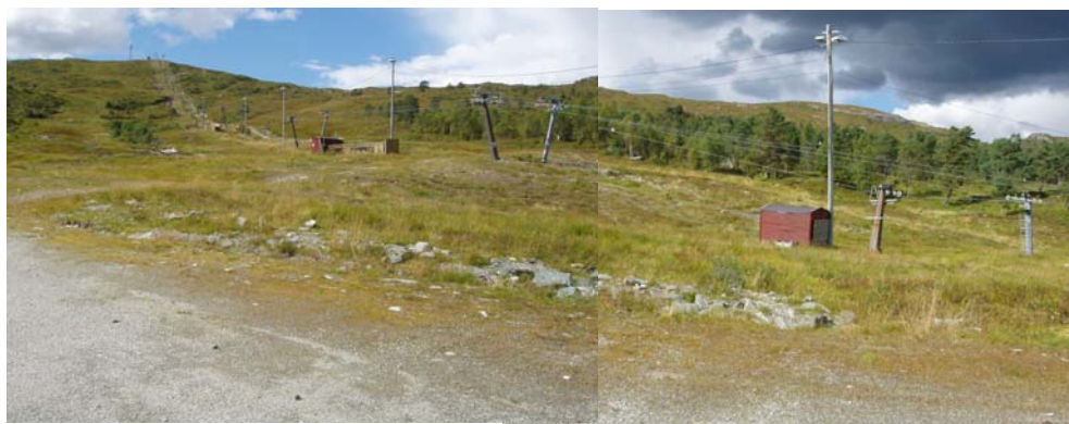
Fig. 21 Heisanlegget i Furedalen
