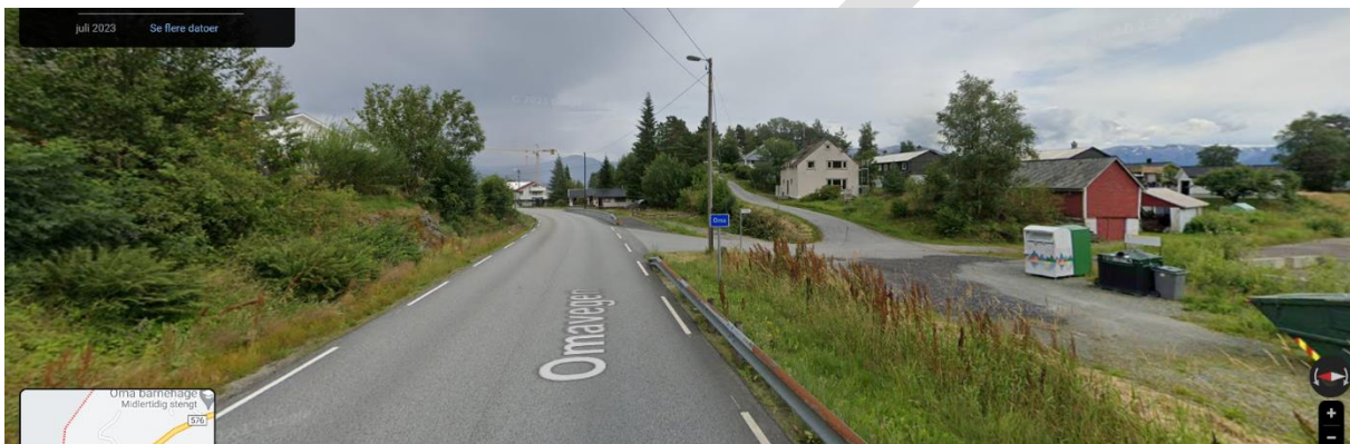
Figur 15 Utsyn mot eksisterende avkjørsel på høyre side -- her planlegges nytt kryss med fylkesveien.
