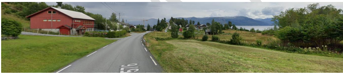
Figur 12 Utsyn etter garasje 134/9 mot utløe/grindebygg – her planlegges ingen tiltak på 134/9.
