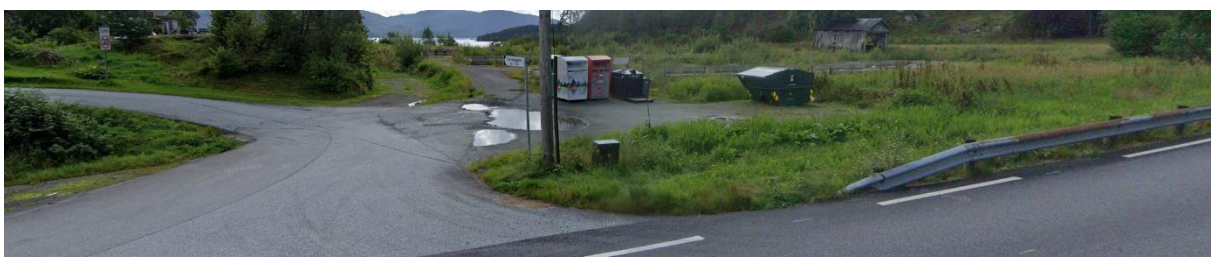
Figur 17 Utsyn mot eksisterende avkjørsel – her planlegges nytt kryss med fylkesveien.
