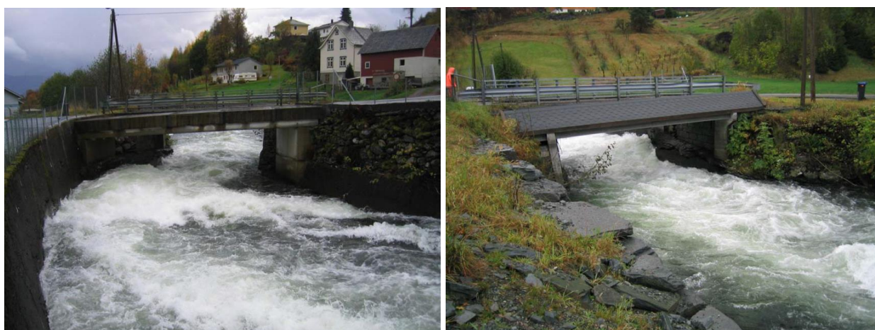
Figur 4-6. Sjusetevegen bru. Til venstre: sett fra oppstrøms. Til høyre: sett fra nedstrøms. Foto: Novatek, 2007 [11].
