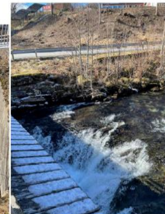
Oppstrøms Holmane bru
