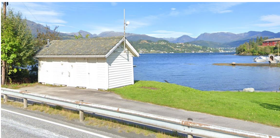
Figur 10 Bilde som viser eksisterende avløpspumpestasjon (kjelde: Google maps)
