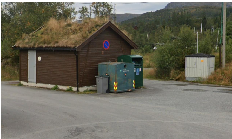
Figur 6 Bilde av pumpestasjon ved Tokagjelet (kjelde: Google maps)
