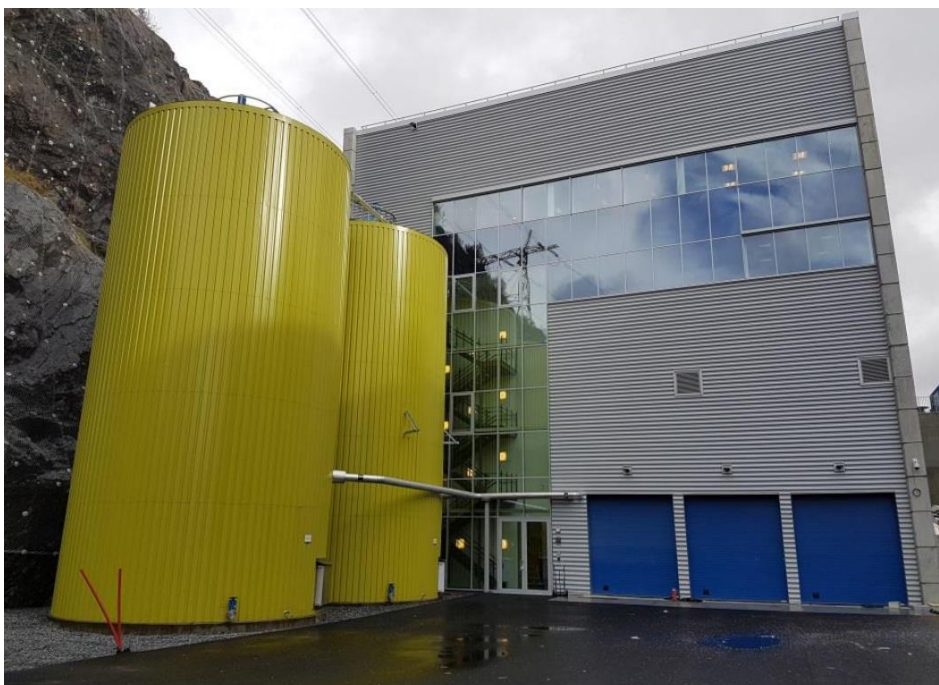
Figur 4: Biogassanlegget i Bergen som mottek slam frå Kvam herad (Kjelde: Bergen kommune)
