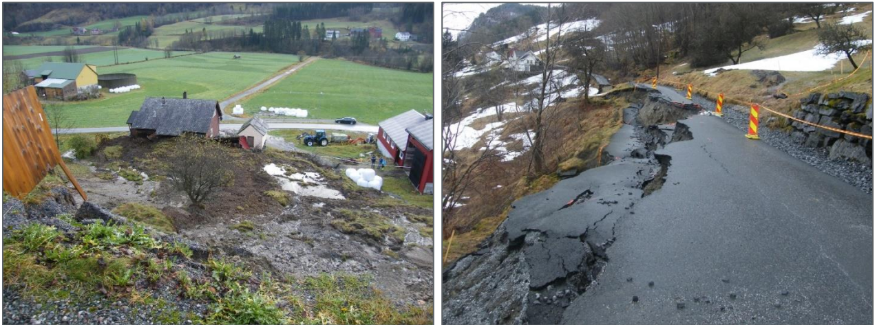
Figur 14: Døme på jordskred (26. og 28.10.2014) og jordsig (28.10-2014–ca. 16.5.2015)
