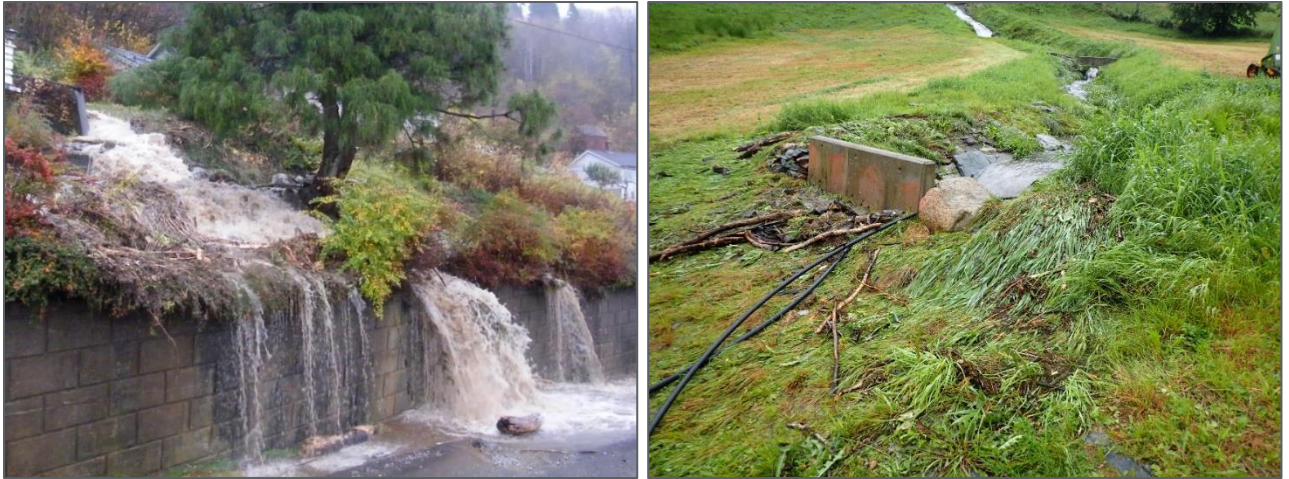
Figur 13: Døme på vatn på avveggar (Norheim, 28.10.2014) og problem med kapasitet når bekken vert lagt i røyr - spor etter styrtbyer (29.8.2019)
