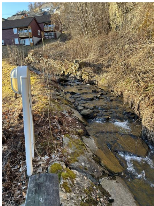
Figur 5-9. Bilde av Øyrabekken omtrent hvor tverrsnittet vist i Figur 5-8 er oppmålt. Bilde: Norconsult
