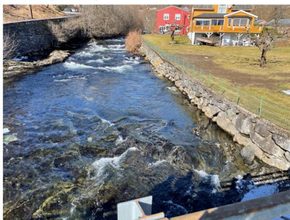
Holmane 9 sett fra Holmane bro og fjellterskel i elven oppstrøms broen
