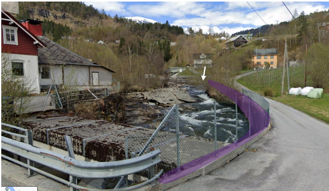
Figur 8-7. Videreføring av uttrykket på plastringen (indikert med hvit pil) som bør videreføres like nedstrøms i tiltak 3 (Foto: Google maps, 2023).
