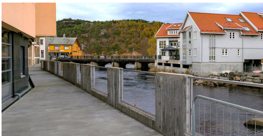
Figur 8-10 Flomvegg med felter med glass for å beholde utsikt og dagslys langs Lundeåna i Egersund (Foto: Eigersund kommune, 2019).
