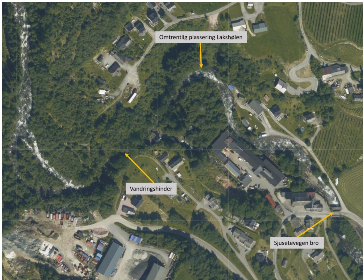
Figur 5-1. Oversikt over funksjonsområder for fisk i øvre del av Øysteseelva. Bakgrunnsbilde: Hardanger 2022 ( www.norgebilder.no ).
