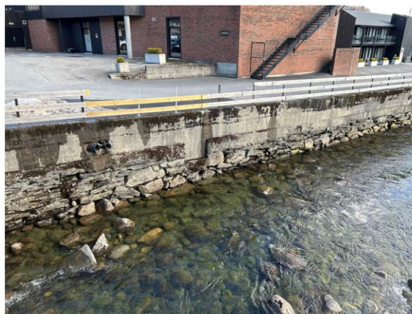
Eksisterende forbygning langs østre elvebredd nedstrøms bro
