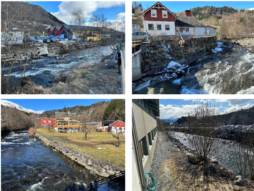
Figur 2-3. Bilder av Øysteseelva med generelle eksempler på bygninger som ligger tett inntil elven og forbygging av elvekanten. Bilder: Norconsult
