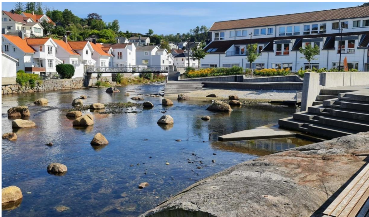
Figur 6-2 Elveparken langs Lundeåna i Eigersund sentrum. Det er en sammensatt flomsikring som gir mange muligheter for kontakt med elven (Foto: Facebook-gruppen Smånytt fra Eigersund, 2020).
