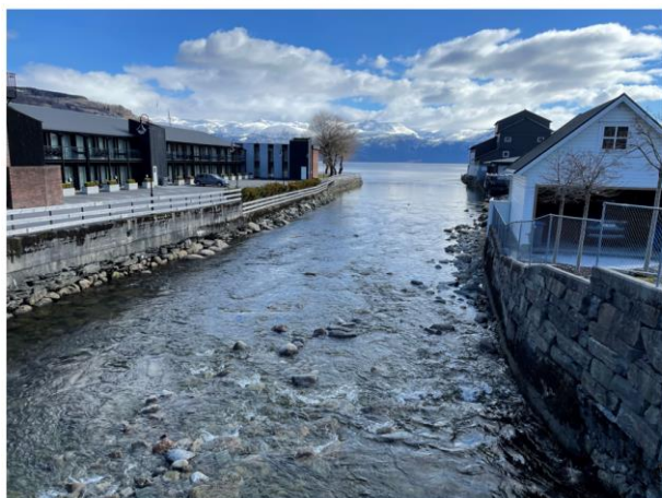
Strekning nedstrøms bro ved utløp i Hardangerfjorden
