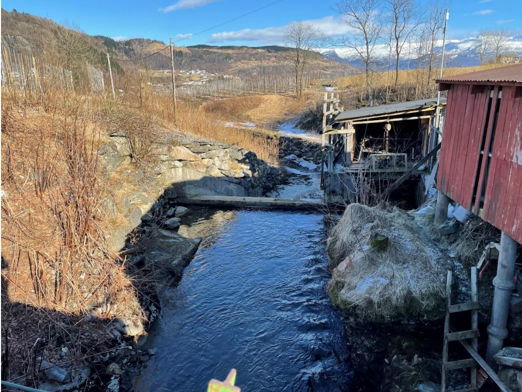
Figur 12: Dammen sett medstrøms
