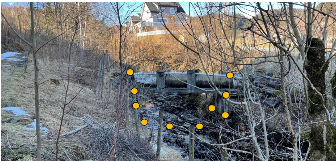
Figur 19: Bilde fra bru b7, kryssing av rørgate
