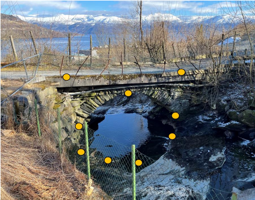
Figur 16: Oversikt av oppmålte punkter på oppstrøms siden av bru
