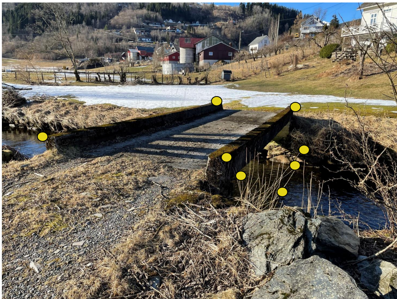
Figur 6: Bilde fra bru B3, kryssing ved landesvei
