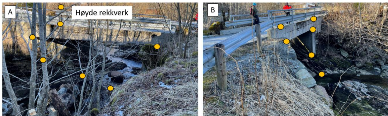
Figur 21: Oversikt av oppmålte punkter på A) oppstrøms og B) nedstrøms side
