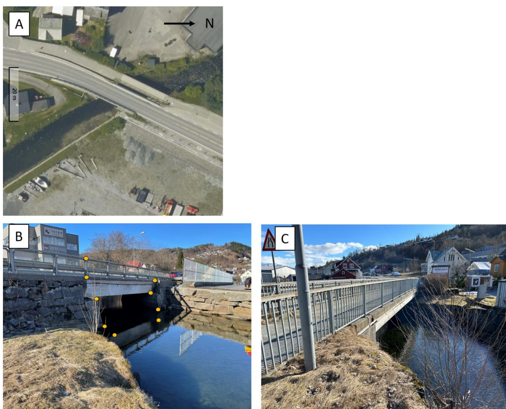
Figur 24: Bilder fra bru 1 (kryssing med fylkesveien) – A) Oversiktsbilde B) sett fra nedstrøms C) sett fra oppstrøms
