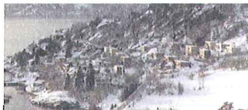
Bebyggelsen på Skjæret er eksponert mot riksvegen og står fram som ei unik husgruppe i vårt distrikt.
