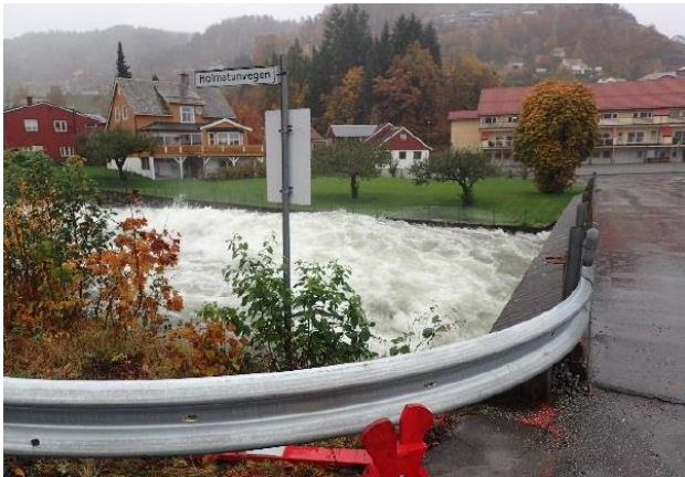
A) Forhold oppstrøms Holmane bru under flommen i 2018 (sett oppstrøms).
