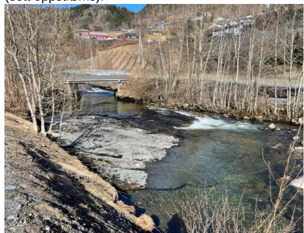
F) Fjellterskel nedstrøms Sjusetevegen bru (sett oppstrøms).
