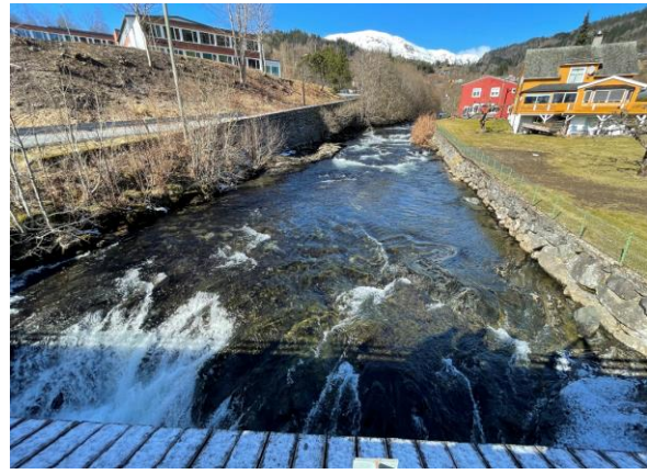
B) Forhold oppstrøms Holmane bru. Tørrmur på begge sider av elva, med stor høydeforskjell (sett oppstrøms).
