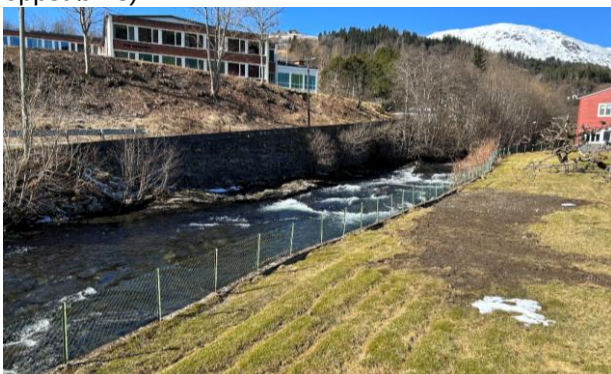
E) Utsikt oppstrøms mot ungdomsskole. Tørrmur på østsiden av elva, med betong på toppen (sett oppstrøms).
