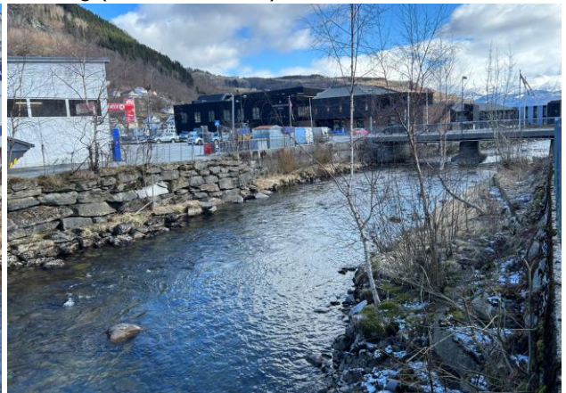
D) Forhold oppstrøms Hardangerfjordbrua, sett medstrøms mot Sjusetevegen 4. Tørrmur. Løsmasser i elvebunnen.
