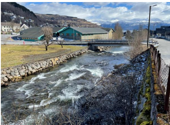
C) Utsikt mot Holmane bru fra vestsiden av elva. Fastfjell oppstrøms brua (sett medstrøms).
