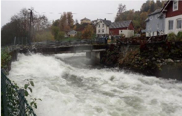
A) Skjevstrømning oppstrøms Sjusetevegen bru under flommen i 2018 (sett medstrøms).
