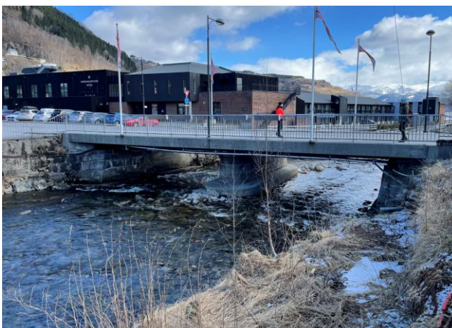
E) Hardangerfjordbrua og brupilar (sett medstrøms).
