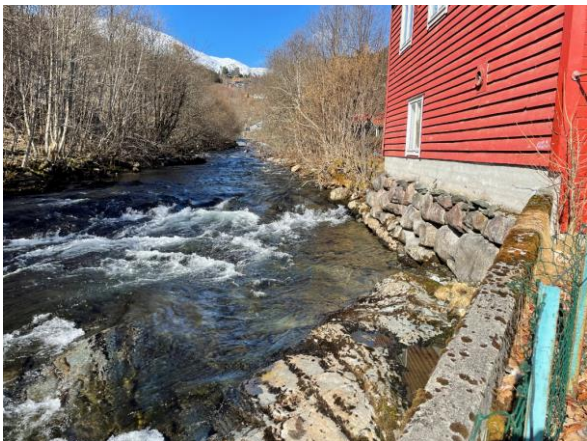
C) Holmane 7 (bolig) ved elva. Betongvegg og erosjonssikring i stein. Fastfjell ved elvebredden (sett oppstrøms).
