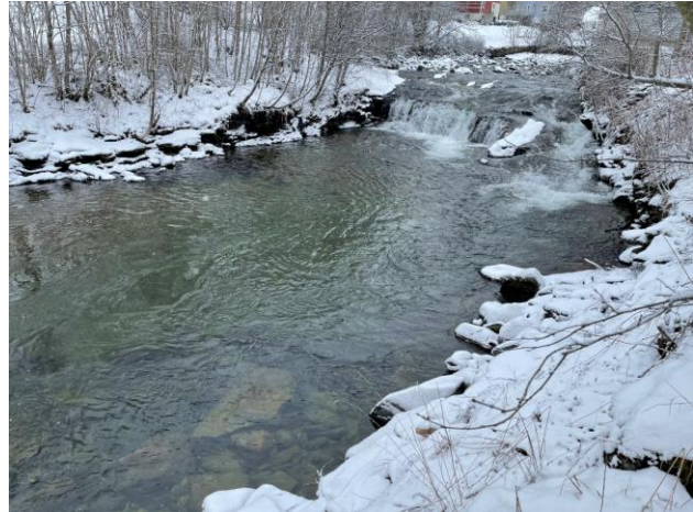
B) Fiskekulp ca. 25 m nedstrøms Sjusetevegen 56. Dynamisk løsmasseterskel nedstrøms fiskekulp (sett oppstrøms).
