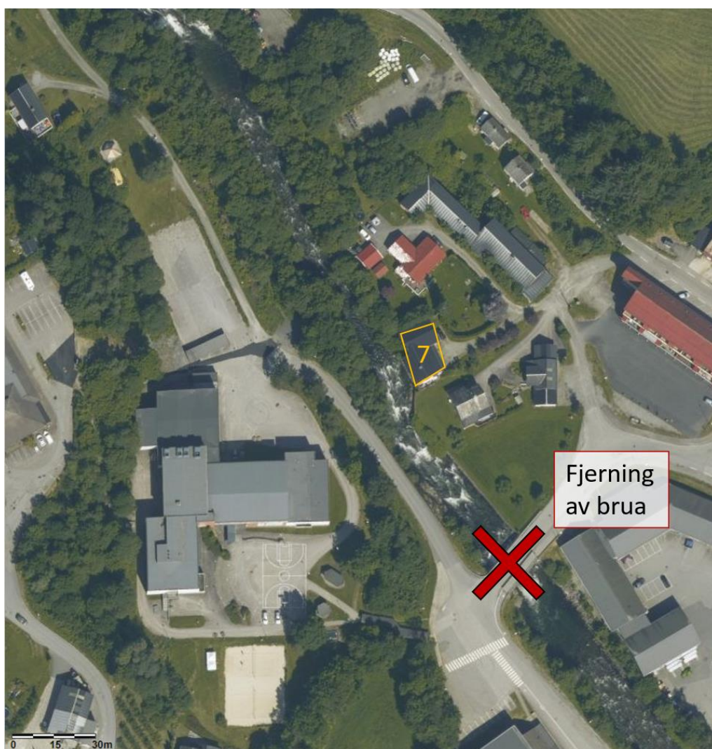
Figur 2-18. Fjerning av Holmane bru.
