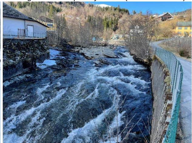
D) Fastfjell direkte oppstrøms Sjusetevegen bru (sett oppstrøms).
