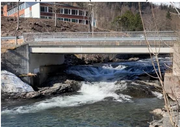
E) Fjellterskel oppstrøms Holmane bru og fastfjell gjennom brua. Djupål sentrert gjennom lysåpning (sett oppstrøms).
