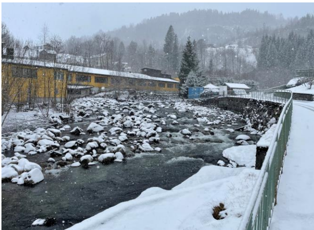
C) Mye løsmasser oppstrøms Sjusetevegen bru (sett oppstrøms).
