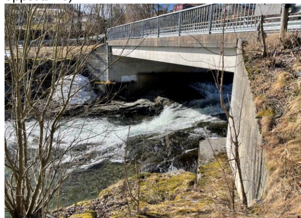
D) Strømningsforhold under Holmane bru (sett oppstrøms).
