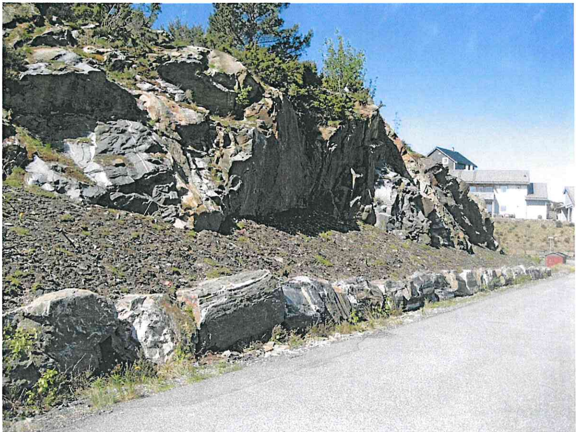
Steinkant langs skjæring - sidetak
