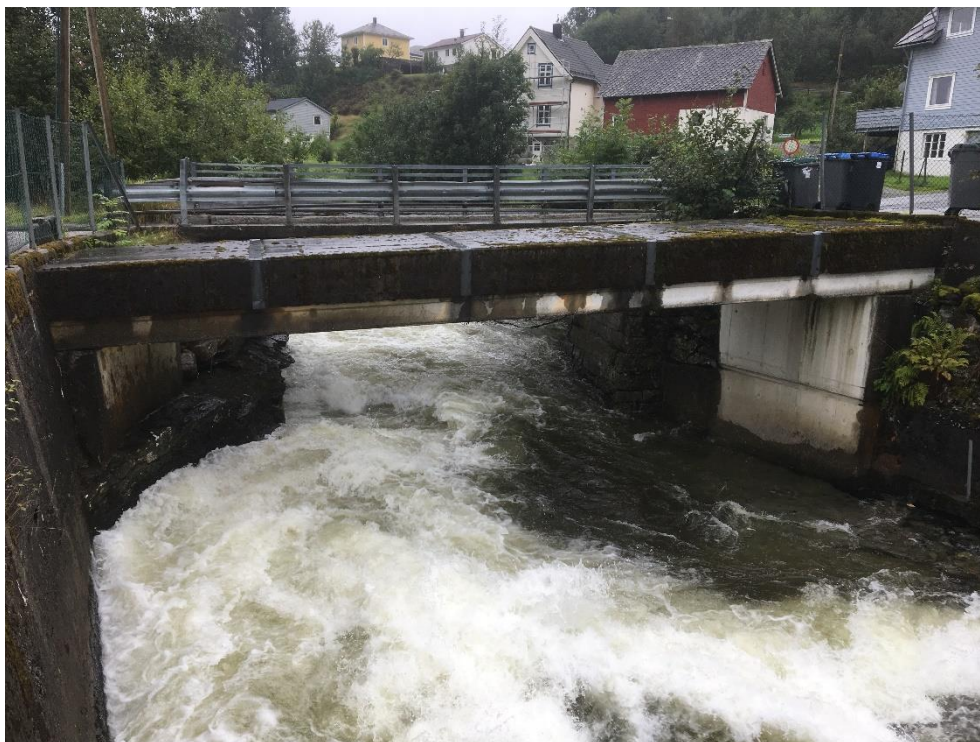
Figur 2. Bru ved Sjusetevegen.
