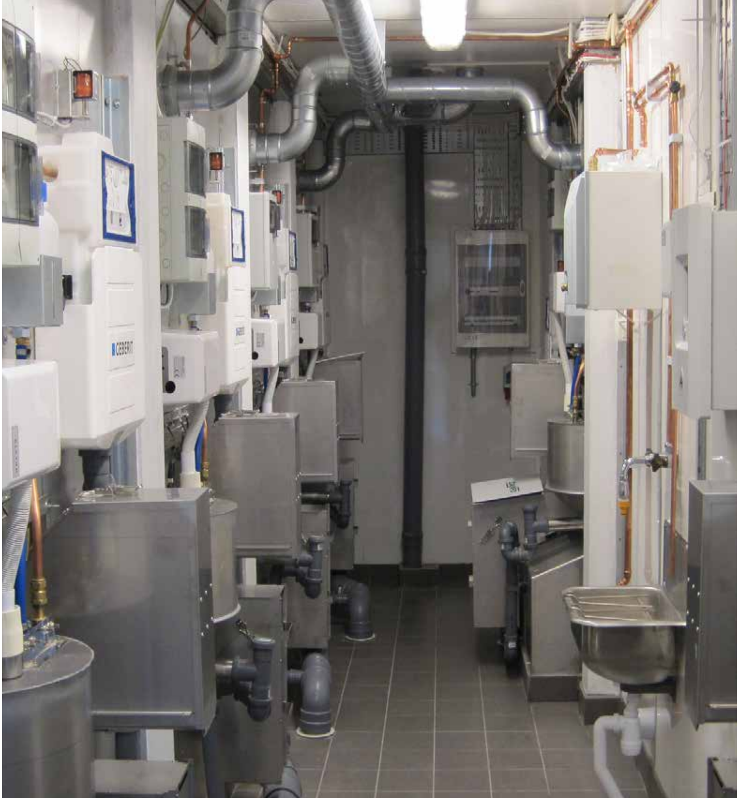
Frå Danfo.com sin brosjyre "Modulet - innbyggnadssystem för offentliga toaletter". Me ser at dei byggjer enkle, lett drivne toalett med all teknikk samla i servicerom i bakkant.
