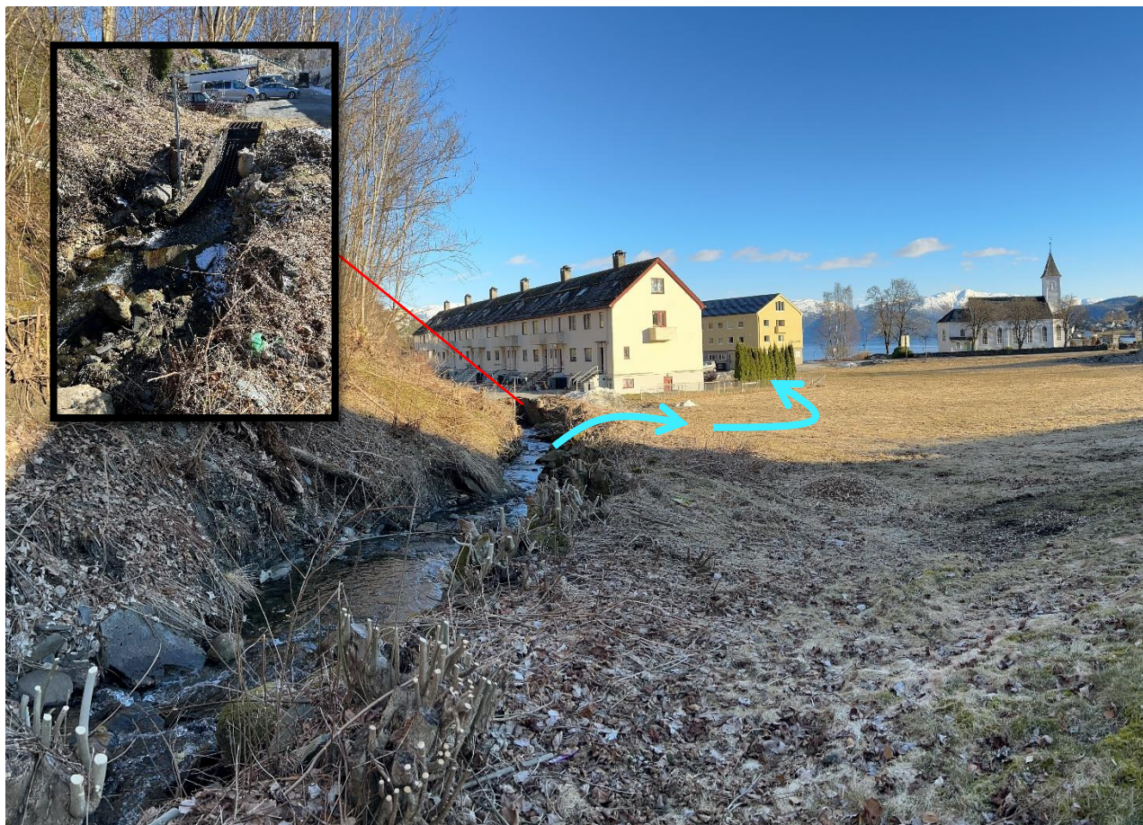
Figur 5-2. Bilde fra befaring av Øyrabekken ved innløpet til overvannsrøret. Bildet viser hvor Øyrabekken går inn i rør som danner et kritisk punkt som fører til at bekken renner ut på høyre bredde (sør) og ut over Mikkjelsflaten. Bilde: Norconsult
