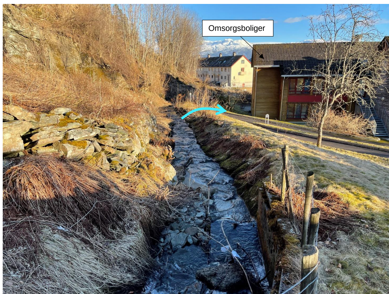
Figur 5-1. Bilde fra befaring av Øyrabekken ovenfor Mikkjelsflaten omsorgsboliger. Bildet er tatt omtrent i 'svingen' hvor bekken går fra bratt til slakere helning og viser skråning med tørrmur på venstre side (nord) og lavere terreng på høyre side (sør). Bilde: Norconsult
