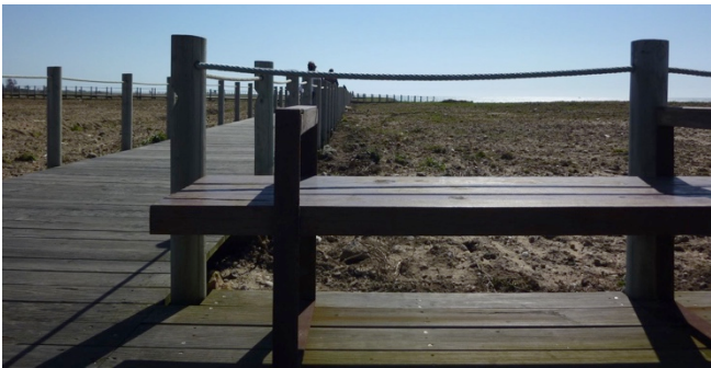
Maritimt rekkverk langs pir på pæler
