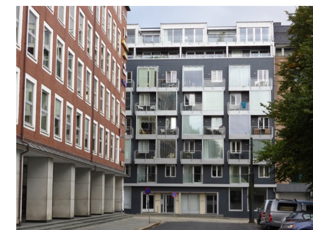
Eksempel fra Bergen: moderne glassveranda som klima- og støy-buffer; arkader langs bygget til venstre.
