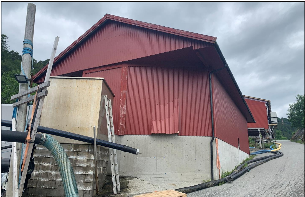
Figur 4: Bilete av eldre anleggsbygning.
