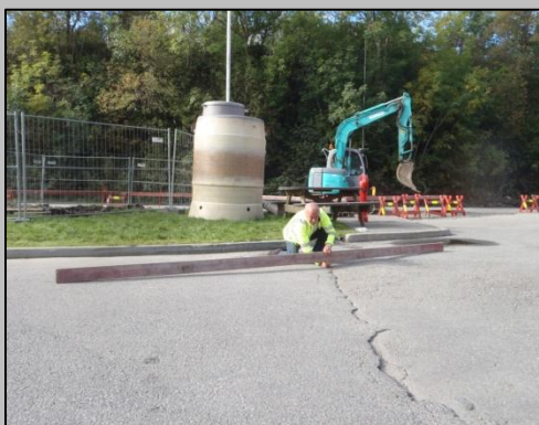
Det settes krav til maksimum setning på grøfter som er 3 år gamle
