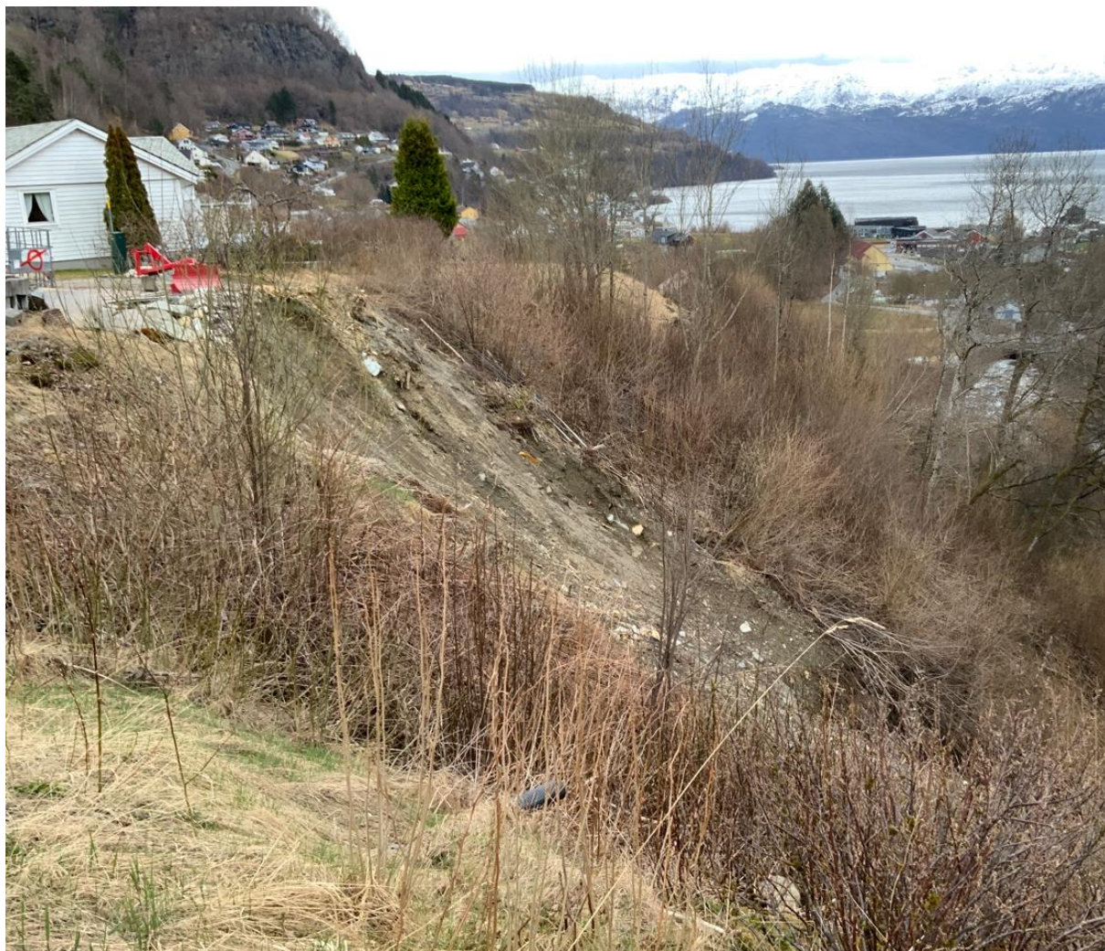
Figur 8: Eksempel på overflateskred etter last/utfylling ved topp skråning. Denne typen skred er ikke vurdert i denne rapporten med mindre de kan berøre sprøbruddmateriale.
