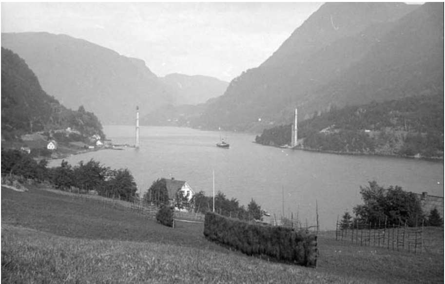
Fykkesund bru under oppføring. Foto: Truls Wiel Wilson / Spesialsamlingane ved Universitetsbiblioteket i Bergen
