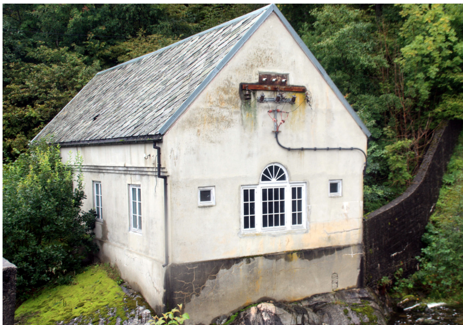
Kraftstasjon i Ytre Ålvik, i drift frå 1916. Foto: Øyvind Strømmen.
