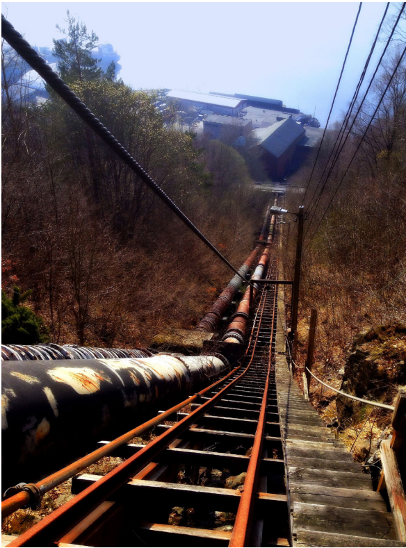
Frå røyrkata til Bjølvfossen. Foto: Knut Markhus.
