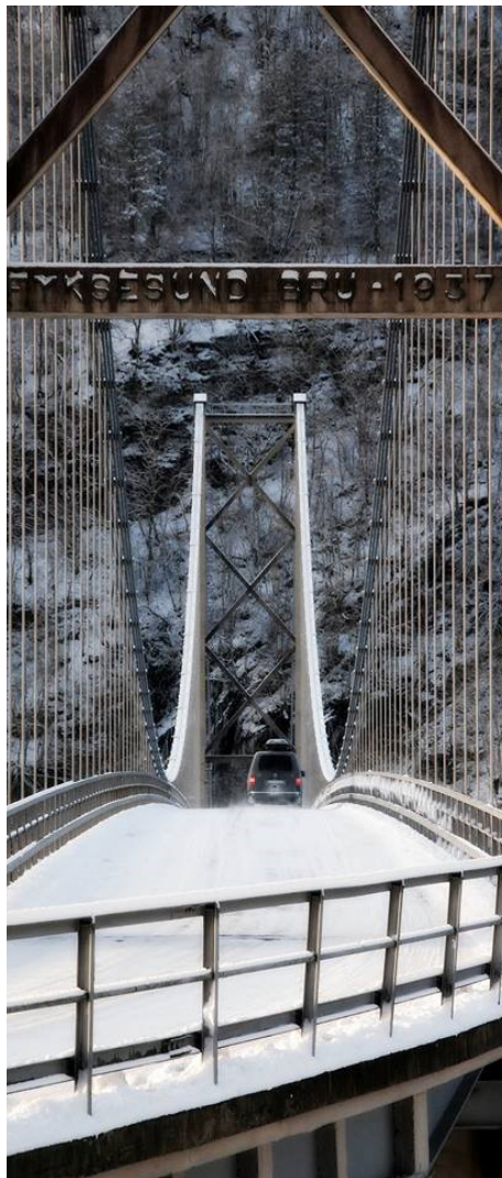
Fykkesund bru - bygd i 1937. Foto: Knut Markhus.
