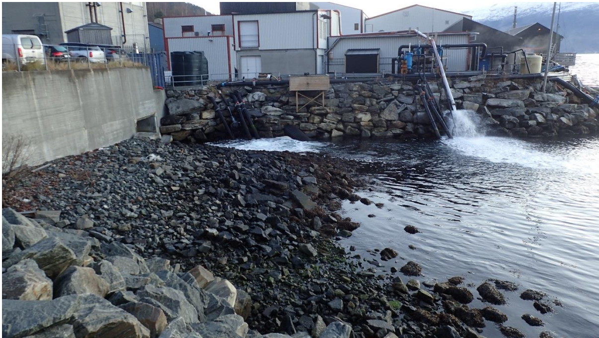
Bilde V10.1. Settefiskanlegget sett fra vestlig mot østlig retning som viser rørarrangementet like utenfor anlegget.
