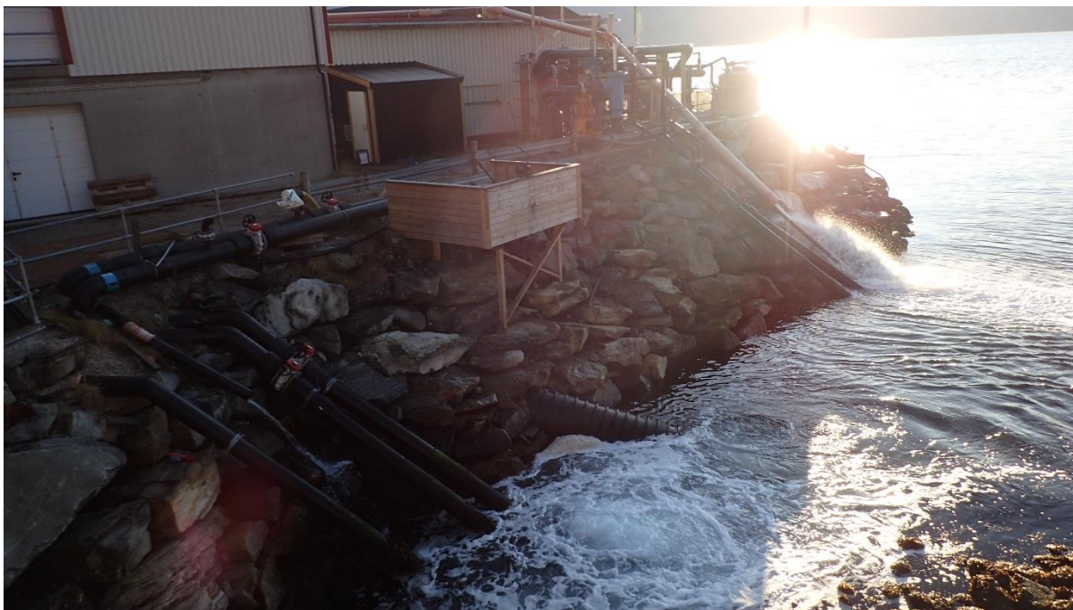
Bilde V10.14. Viser rørarrangementet like ved anlegget.
