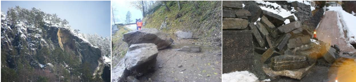
Figur 13. Døme på steinskred. Til venstre kan ein sjå losneområdet til eit steinskred i Ålvik i 2015 som gjorde mykje av seg, men ingen vart skada. Bilde i midten viser steinsprang på Klyvevegen i 2008 og bilde til høgre er ikkje eit steinskred, men ein mur som ramla ned i 2010 og kan meir reknast som ei ulukke enn eit skred.
