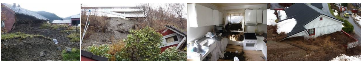
Figur 11. Døme på jordskred som har gjort skade på eigedom i 2014 og 2015.
